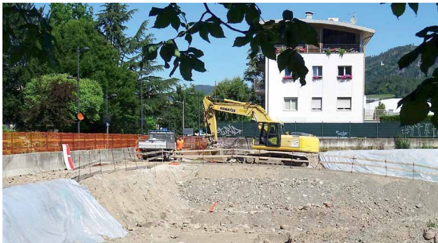
• Si è tornati a lavorare nel cantiere per il parcheggio interrato ai Canopi dopo lo stop per i ritrovamenti archeologici e il lockdown
