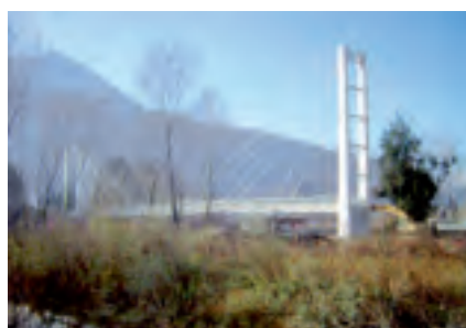
Intervento carpenteria metallica
