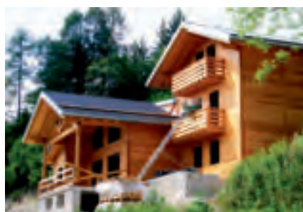
Casa in legno in costruzione
