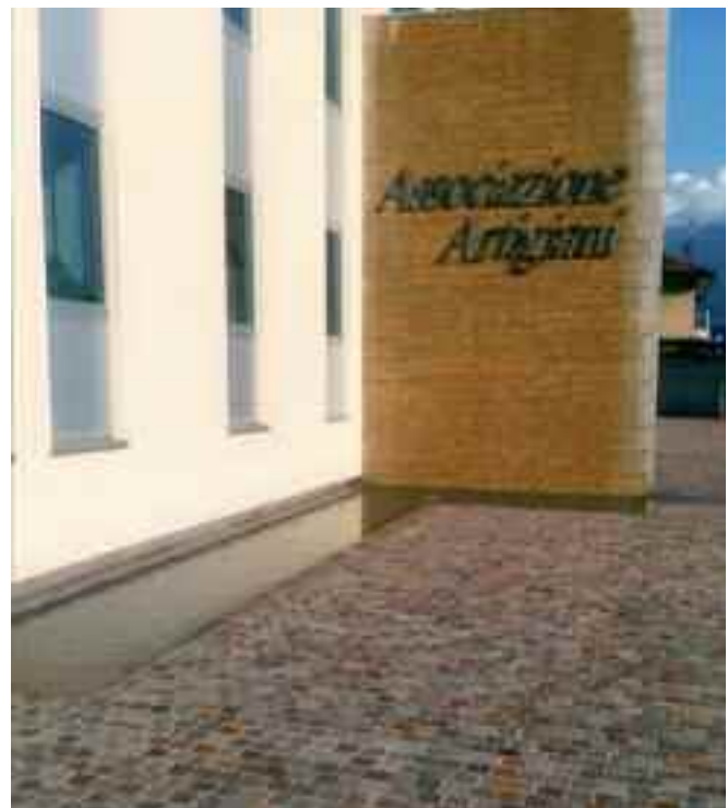
Posa e rivestimenti in porfido eseguiti dal Consorzio
