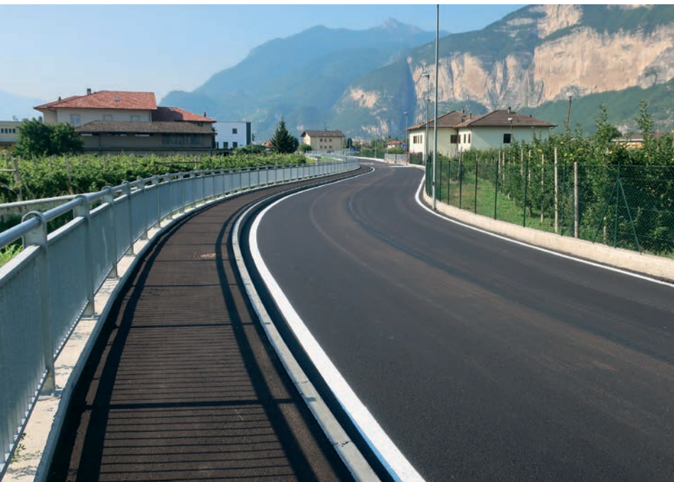
► Sistemazione via Crosare
