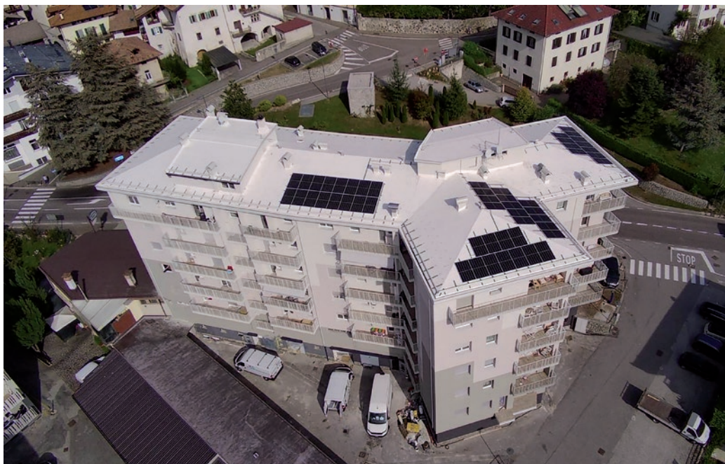
istrutturazione completa, con isolamento termico a cappotto in lana minerale, rifacimento poggiali, guaina sul tetto e lattoniere
